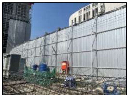
ภาพที่ 3 รั้ว Metal Sheet ความสูง 6 เมตร
